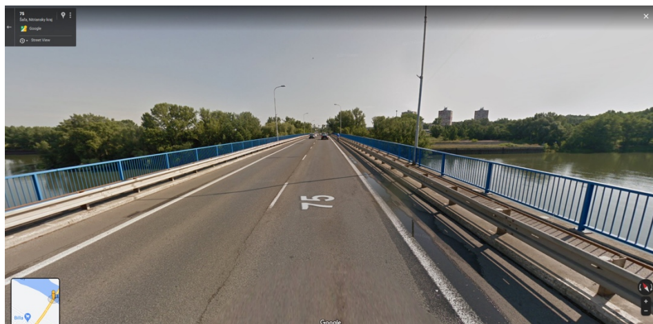
Obr. č. 33: Šaľa cestný most I/75 cez Váh, v strede mosta, vzadu ľavobrežná hrádza
