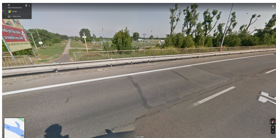
Obr. č. 35: Šaľa cestný most I/75 cez Váh na ľavom brehu Váhu, pohľad na hrádzu sever
