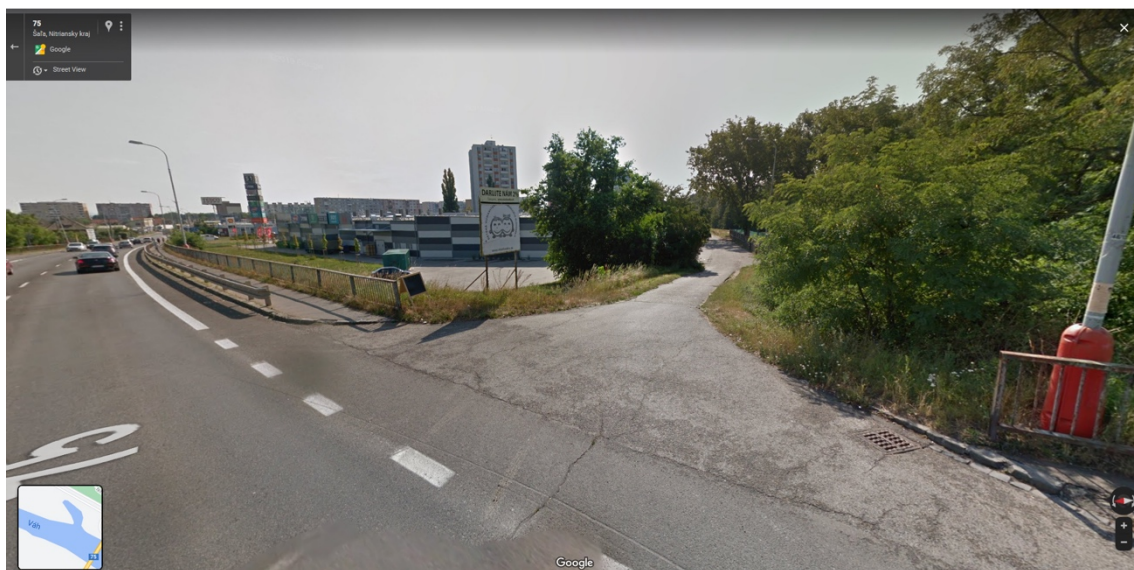
Obr. č. 36: Šaľa cestný most I/75 cez Váh na ľavom brehu Váhu, pohľad na hrádzu juh
