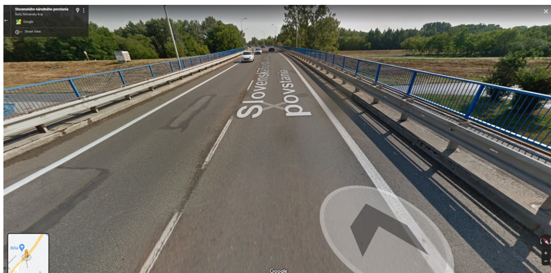
Obr. č. 29: Šaľa cestný most I/75 cez Váh na pravom brehu Váhu, vzadu vidno hrádzu
